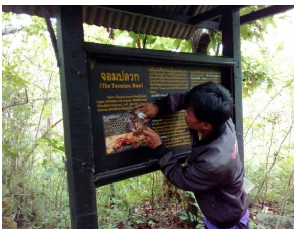
ปรับปรุงซ่อมแซมป้ายสื่อความหมาย ตามเส้นทางเดินศึกษาธรรมชาติ ระยะทาง ๓ กิโลเมตร
