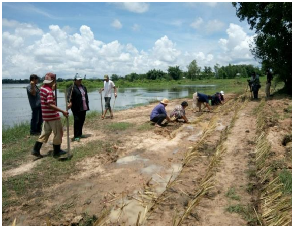
การปลูกหญ้าแฝกรอบอ่างเก็บน้ำห้วยทรายขมิ้น
